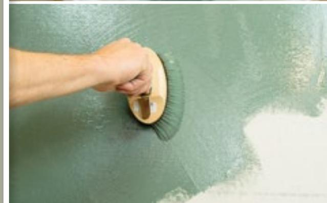
8. Pigmente in Kreidezeit Wandfarben und Putzen hellen erheblich während des Trocknens auf. Links, frisch aufgetragene Farbe, rechts getrocknete Farbe in derselben Pigmentierung.
