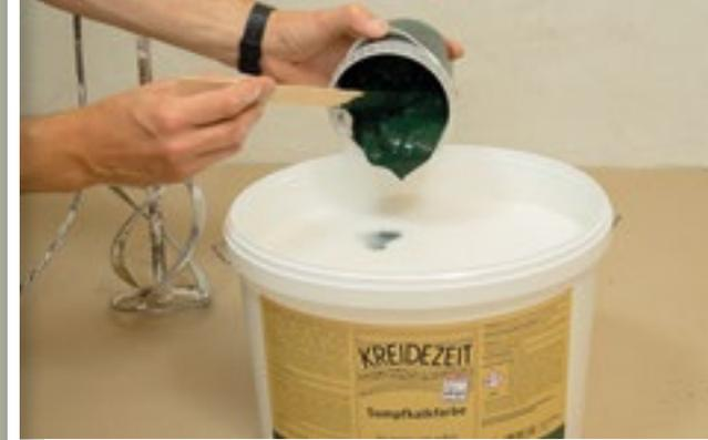
6. Mit einem Rührgerät die Pigmentmischung in die Farbe gleichmäßig einrühren.
